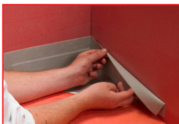
4. Montering av Seal-Strip.
