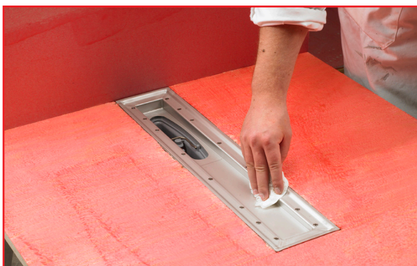
3. Ta bort klämring. Rengör brunnens säte/fläns och avfetta med t.ex. aceton.
