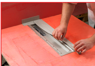
4. Montering av Seal-Strip.
